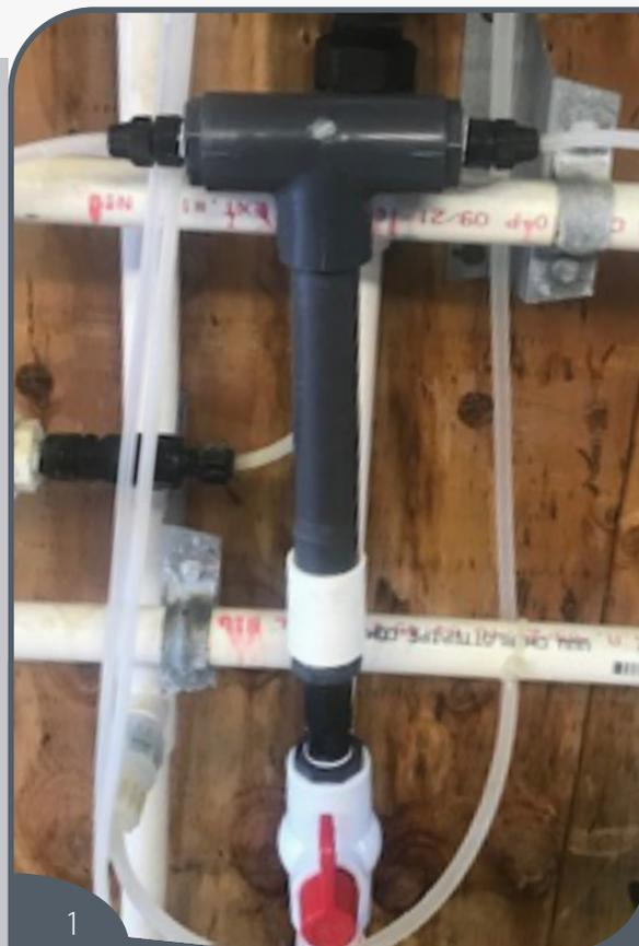
*Una camera di produzione sulla line di abbeverata riduce il tempo di reazione per produrre Diossido di Cloro.*
